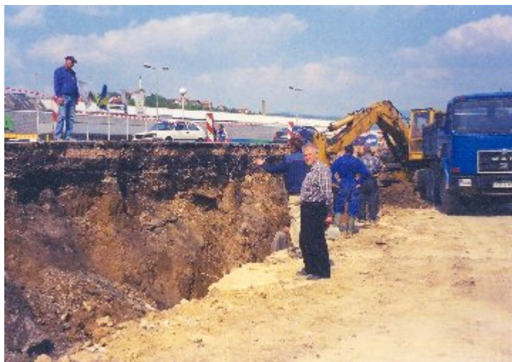
Slika 7.13 Bager, rovokopač angažovan na iskopu rova u okviru izgradnje dijela sjeverne longitudinalne u Sarajevu (Foto: Grcić O., 2006.)
