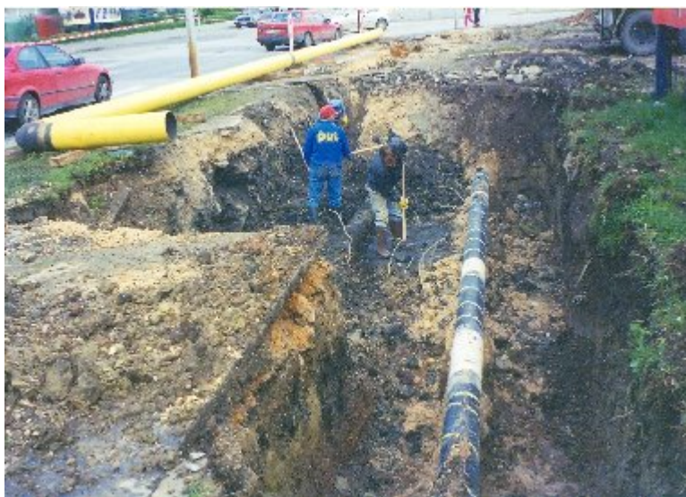
Slika 7.1 Detalj polaganja podzemnih mreža u okviru izgradnje "SJEVERNE LONGITUDINALE" potez od II-ge do III-će transverzale u Sarajevu (Foto: Grcić O., 2006.)
