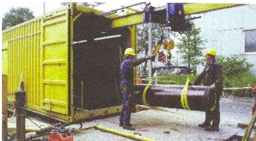
Slika 7.19 Kontejner kod realizacije mikrotunelisanja
