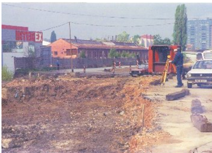
Slika 7.8 Geodetsko snimanje objekata u okviru izgradnje dijela sjeverne longitudinalne u Sarajevu (Foto: Grcić O., 2006.)
