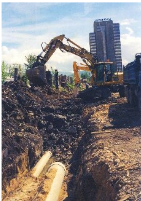
Slika 7.16 Pješčana posteljica rova gdje se polažu kanalizacione cijevi (Foto: Grcić O.,2006)
